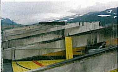
Auch die stark beschädigten Dachträger mussten ausgetauscht werden.
